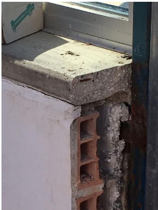
Fig. 2 Sezione della struttura in muratura relativa alle strutture di contorno esistenti
