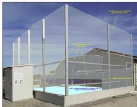
Figura 21 – Impianto di convogliamento aria sul timpano del capannone 5 dotato di n°9 ventole di ricambio d’aria.
