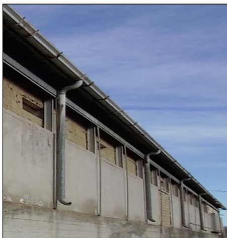
Figura 34 - Pluviali per le acque meteoriche
