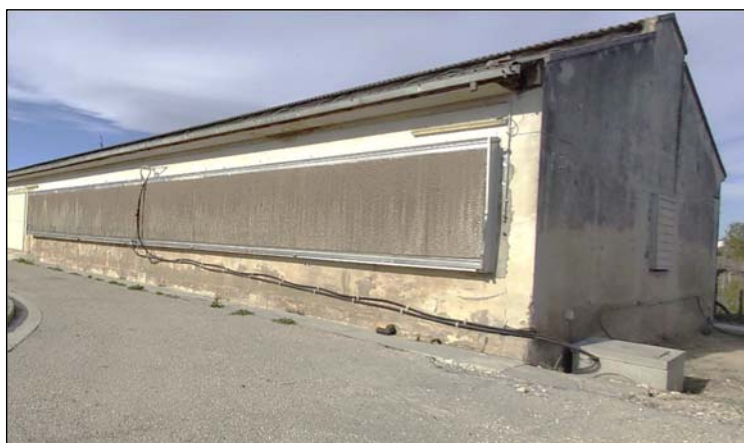
Figura 37 – Pannello evaporativo sistema di cooling
