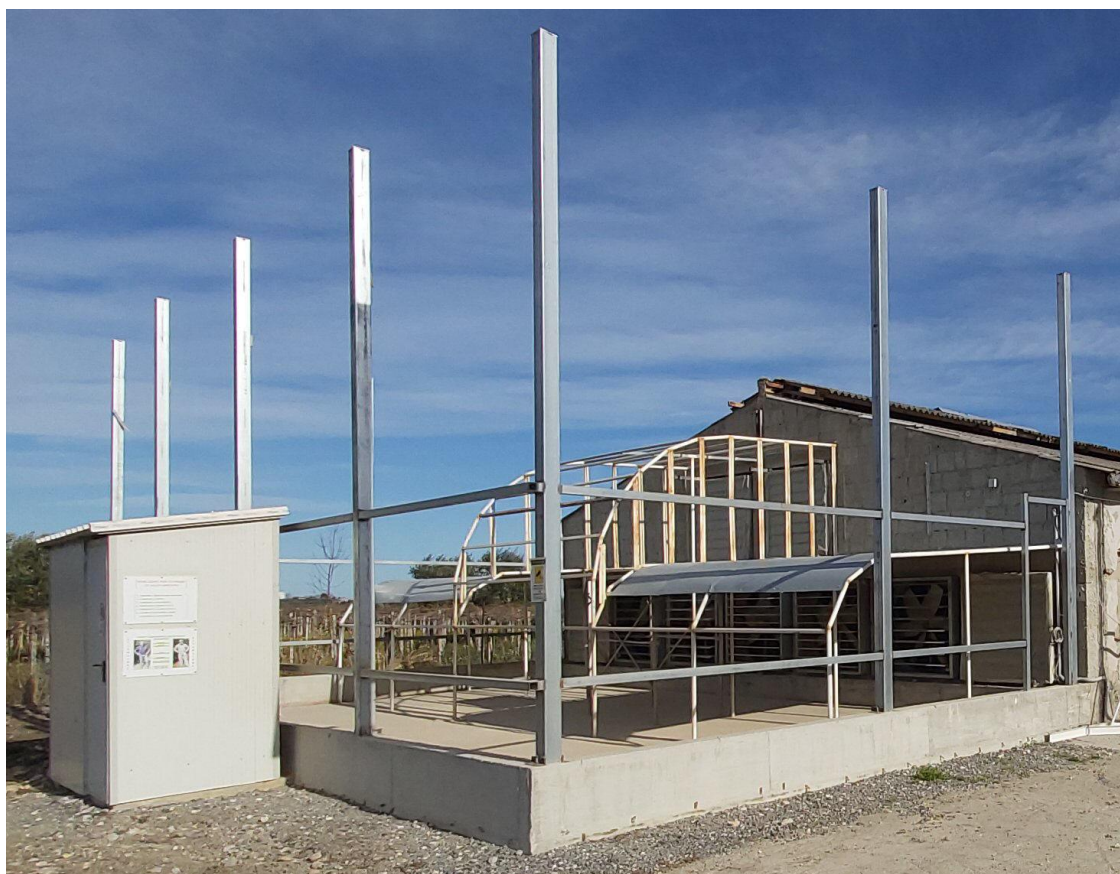
Figure 13 – Impianto in progetto di abbattimento odori già parzialmente realizzato nelle strutture metalliche
