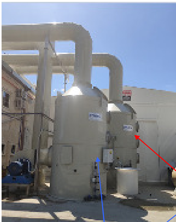
Torre abbattimento SCRUBBER Linea Telaio accorpa le emissioni precedentemente denominate E3 ed E4 oggi denominato EN02
