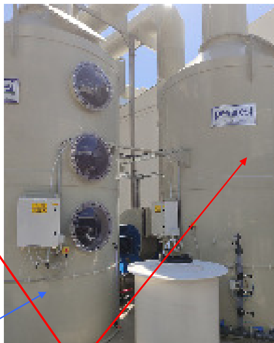
Torre abbattimento SCRUBBER Linea Roto accorpa le emissioni precedentemente denominate E1 ed E2 oggi denominato EN01
