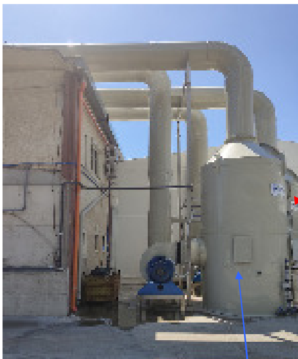
Torre abbattimento SCRUBBER Linea Telaio accorpa le emissioni precedentemente denominate E3 ed E4 oggi denominato EN02
