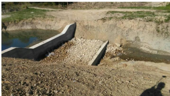
Figura 2: Briglia a monte dell'autostrada – 2017
