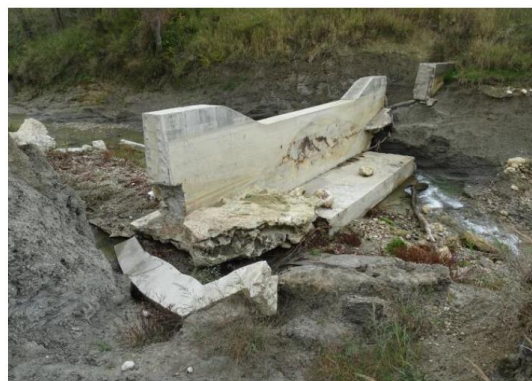
Figura 5: Briglia a monte dell'autostrada – novembre 2020
