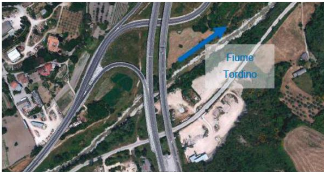
Figura 1 Inquadramento planimetrico viadotto Tordino
