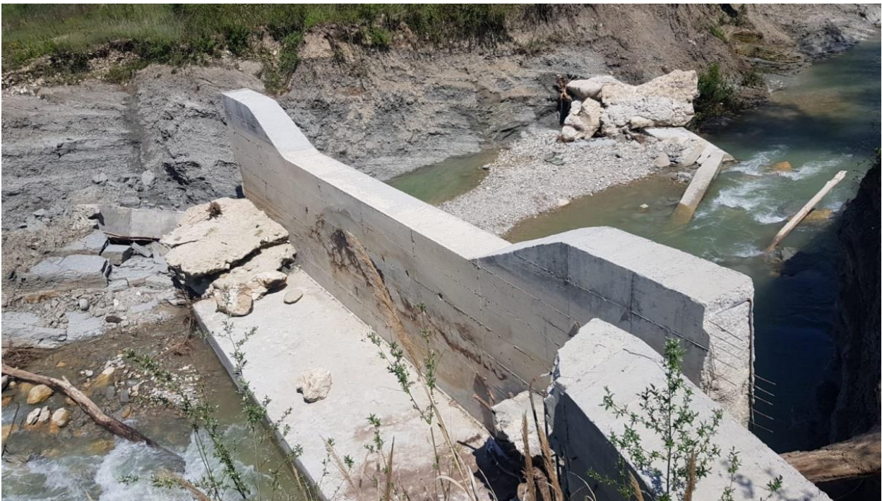
Figura 4: Briglia a monte dell'autostrada – maggio 2020 – briglia spaccata e trascinata a valle
