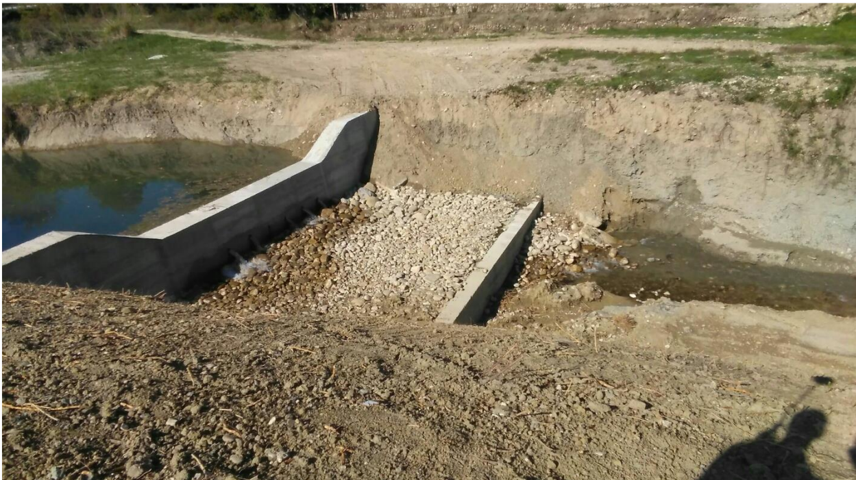
Figura 2: Briglia a monte dell'autostrada – 2017
