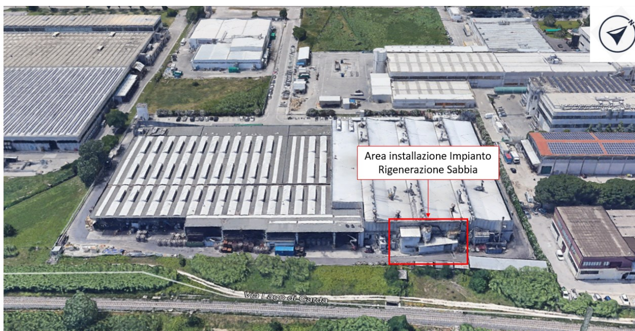
Figura 4-6: Area impianto di rigenerazione sabbia
