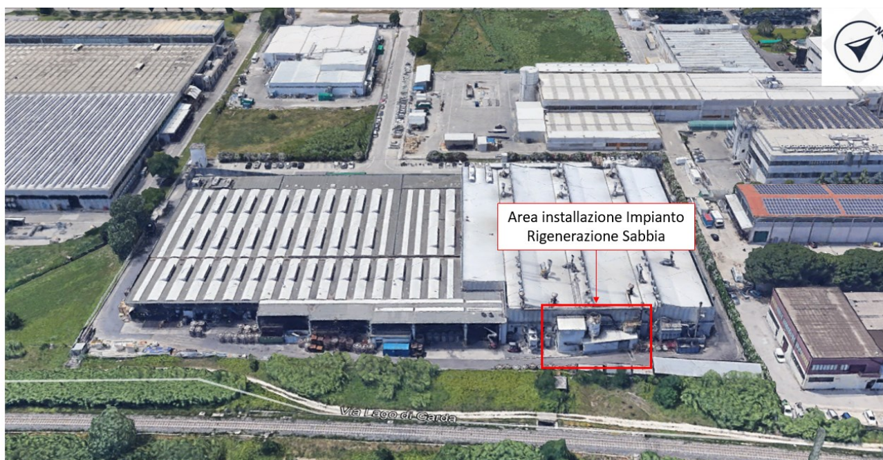
Figura 7-1: Area impianto di rigenerazione sabbia
