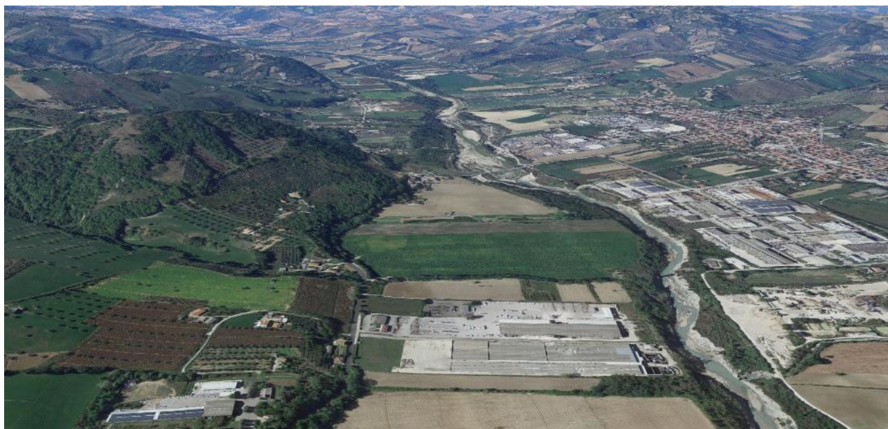
Fig. 36 – Foto del sito in cui verrà realizzato l'impianto nel suo contesto paesaggistico.
