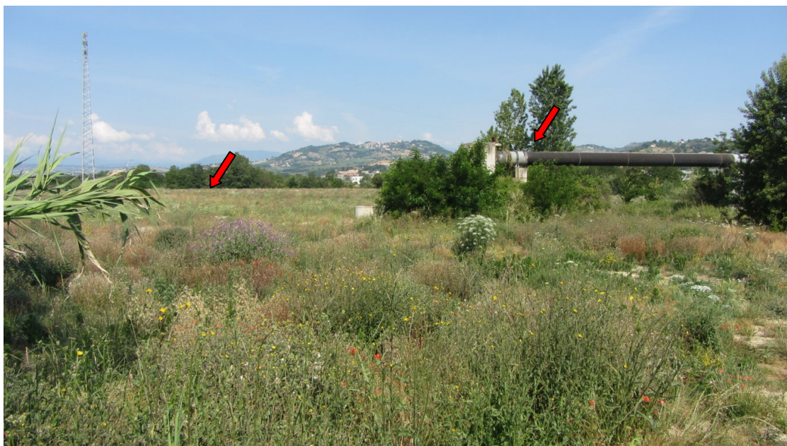
Fig. 6 - Confine NE dell'appezzamento che si estende in avanti; ponte tubo sul Vomano (v. frecce)
