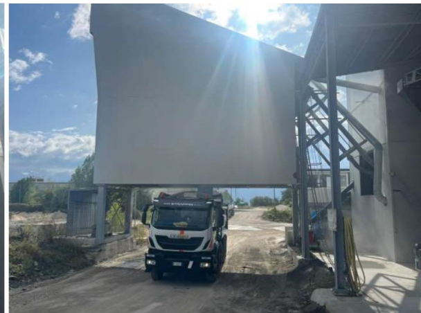
OD2 (Area skip di ricarica tramoggia di carico):
