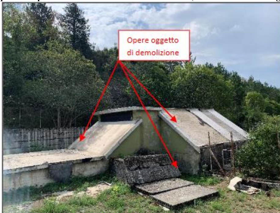
Figura 3. Demolizioni previste in progetto.
