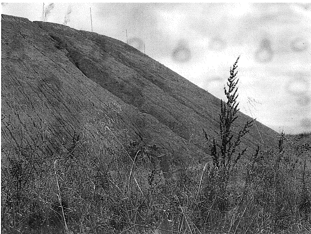
Rilevato in terra posto a contenimento della discarica di nuova realizzazione con evidenti fessurazioni e impronte di ruscellamento superficiale.
