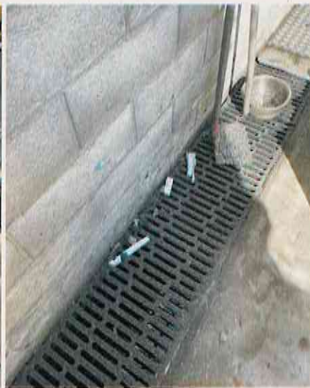
Particolare griglia raccolta acqua
