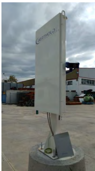
Figura 22 Pannelli installati per la sorveglianza radiometrica
