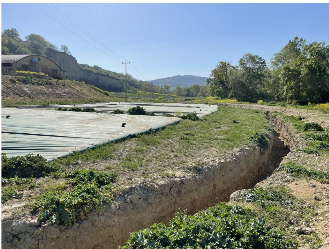
Foto 6: Posizionamento sacconi flessibili e fossa di guardia
