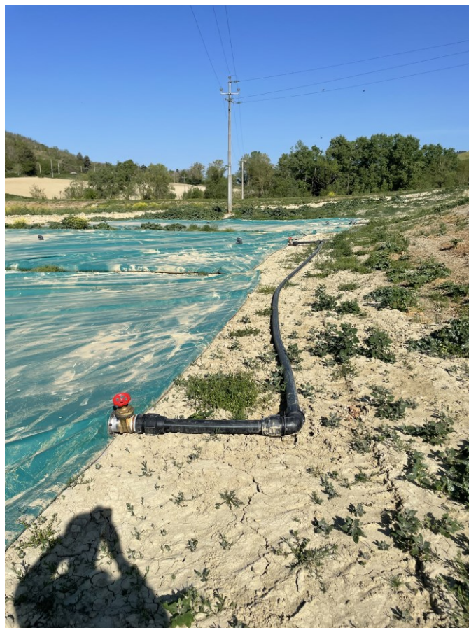
Foto 5: Dettaglio valvole collegamento sacconi flessibili (Big-bag)
