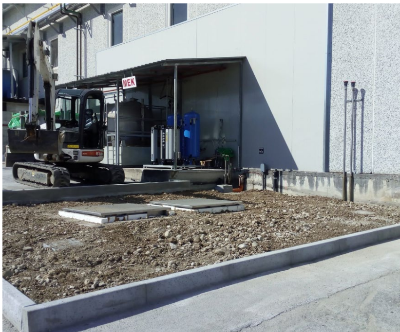
Vista del serbatoio interrato prima della copertura superiore.
