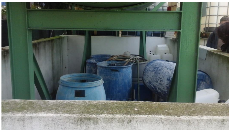
Foto 7: deposito degli imballaggi CER 150110*
