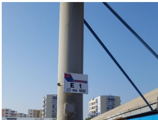
Foto 13: camino E1 fase di decapaggio caustico
