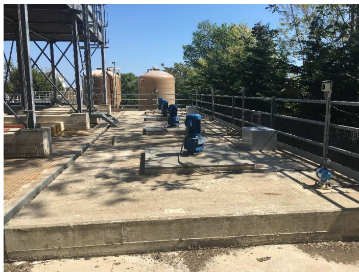
Foto 2: vasca deposito temporaneo D3
