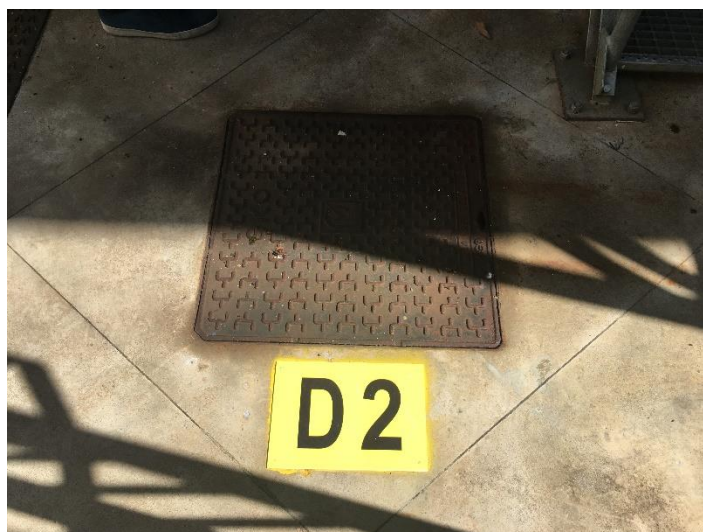
Foto 3 vasca deposito temporaneo D2
