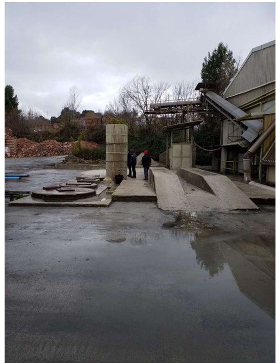
FOTO 4 VASCA DECANTAZIONE ESISTENTE
