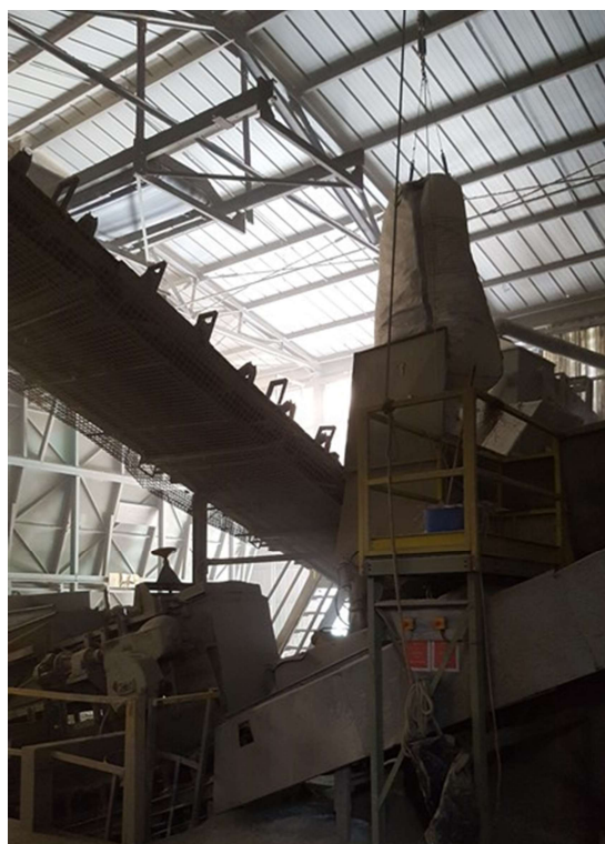
FOTO 9: FORMAZIONE DELL'IMPASTO E SCARICO POLISTIROLO
