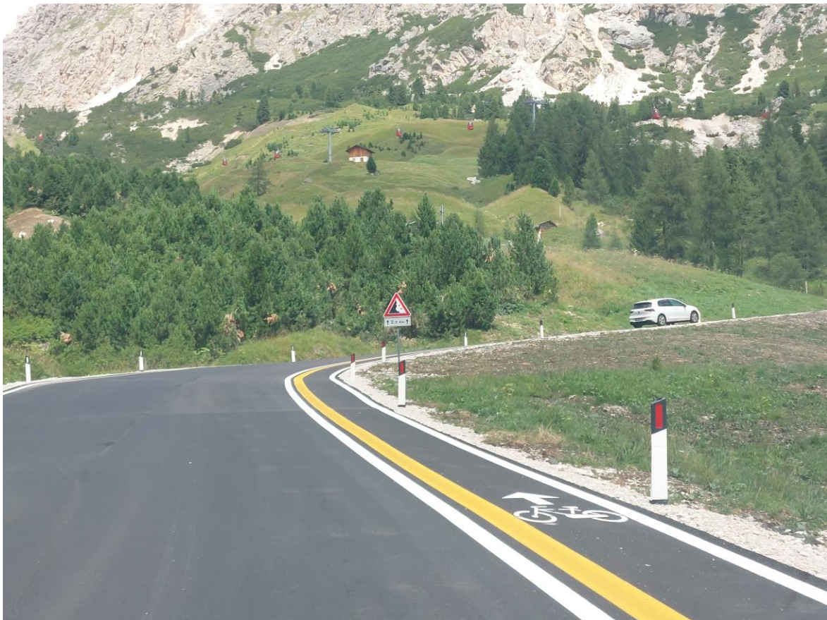
Figura 75 Esempio di corsia ciclabile su strade di montagna
