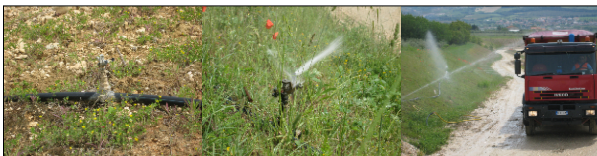
Figura 6-1: Sistema Lafarge per bagnatura della viabilità di cantiere di cava.
